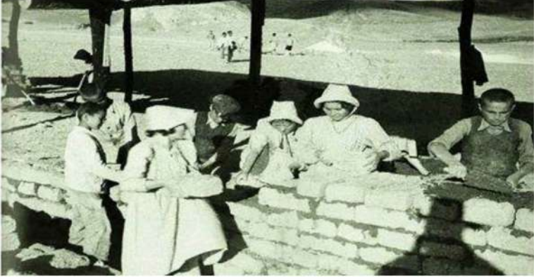
Görsel 6. Hasanoğlan Yüksek Köy Enstitüsü'nde yığma taş duvarların inşa süreci (Güneri, 2014)
