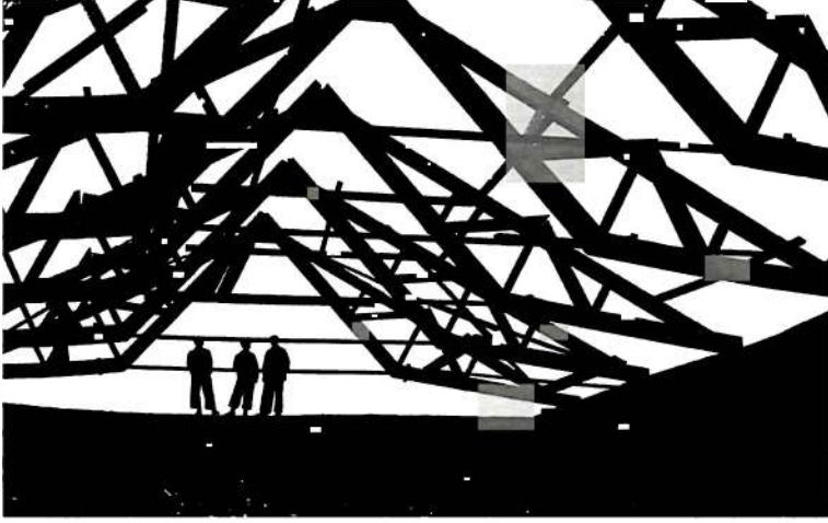
Görsel 8. Hasanoğlan Yüksek Köy Enstitüsü’nde ahşap oturtma çatının inşa süreci (Güneri, 2014)
