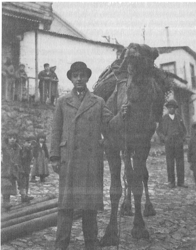
Fasih Saylan, Köprü inşaatlarından birinde. Biga, 1934.
