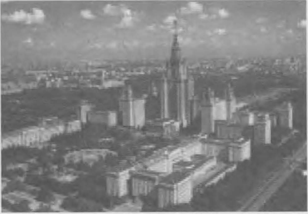
Moskova Devlet Üniversitesi Binası (MGU)
