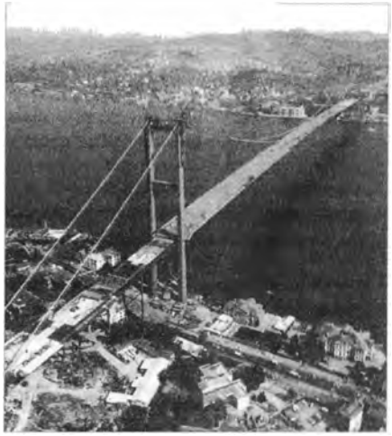
Birinci Boğaz Köprüsü.
