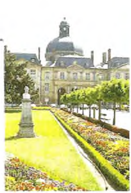
Hôpital Salpêtrière'nin dış cepesi
