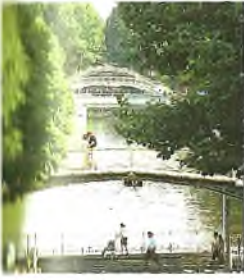
Kanaldaki demir yaya köprüleri ⑤
