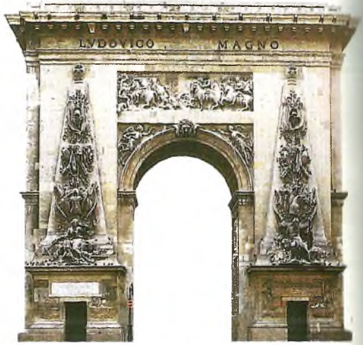
Eskiden kentin girişi olan Porte St-Denis'in batı kemeri
