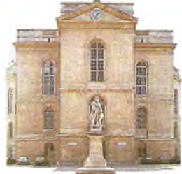
Observatoire'nin ön cephesi
