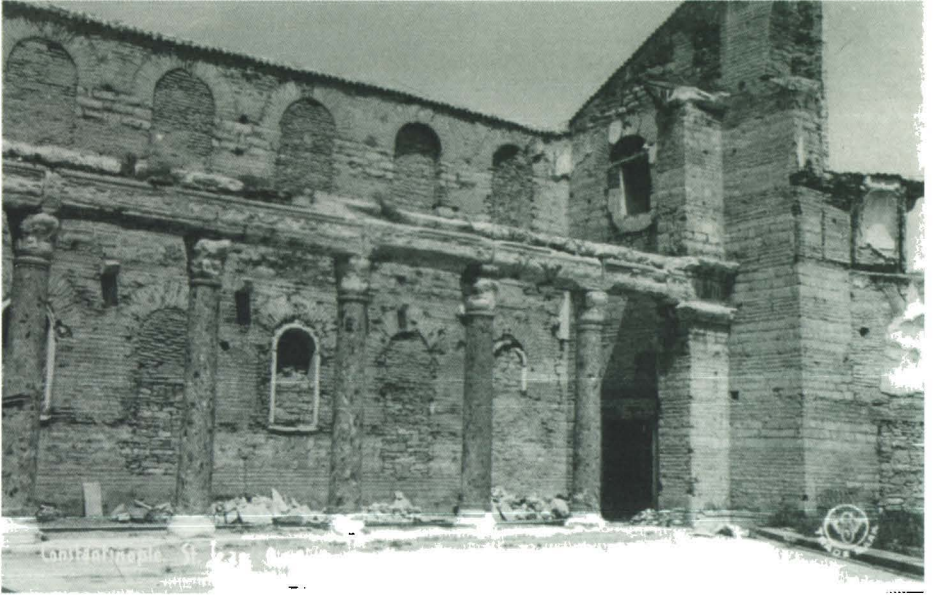
Studios Manastırı (İmrahor Camii) yangından ve depremten geriye kalan görüntü.
