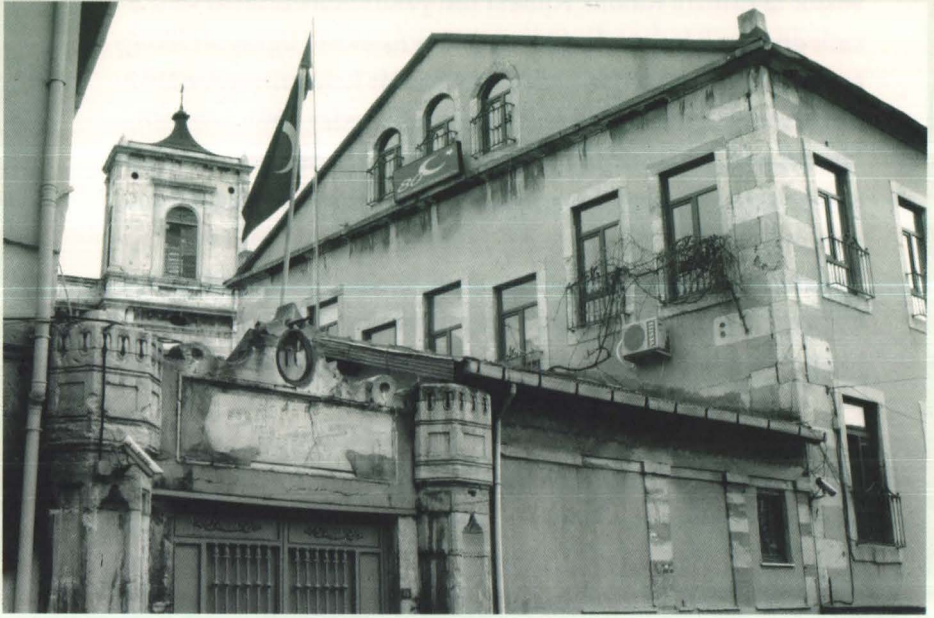
Bizans İstanbulu'nun yedinci tepesinde, eski Perivleptos Manastırı'nın yerinde yükselen Surp Kevork Ermeni Kilisesi'nin çan kulesi ve yanında Sahakyan-Nunyan Ermeni İlköğretim Okulu.
