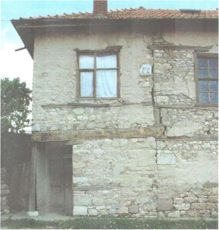
Resim 140. Beyřehir. Eřrefoęlu Seyfeddin Süleyman Bey Câmii karřısındaki evin önyüz duvarı. İnřaatta Roma çağı yapılarından alınma birkaç tařın da kullanıldığı görülüyor.
