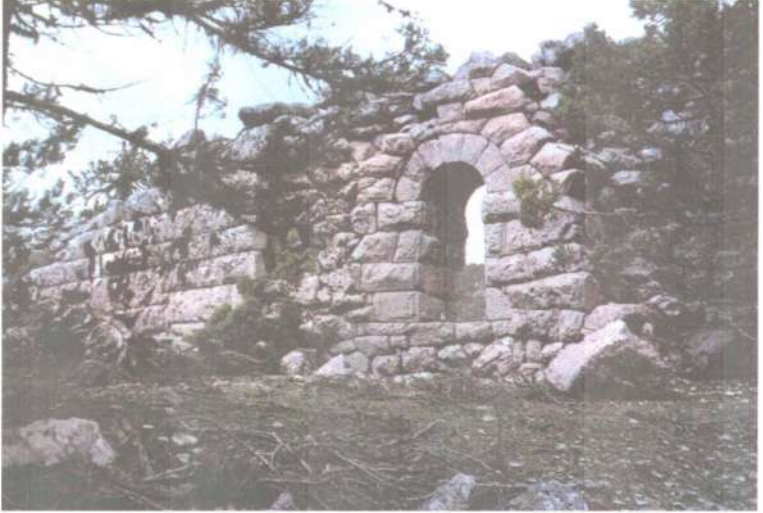
Resim 85. Oinoanda. Kuzey yandaki, ileri dönem surlarında bir ana kapı. İç (kuzey) yandan görünüş.
