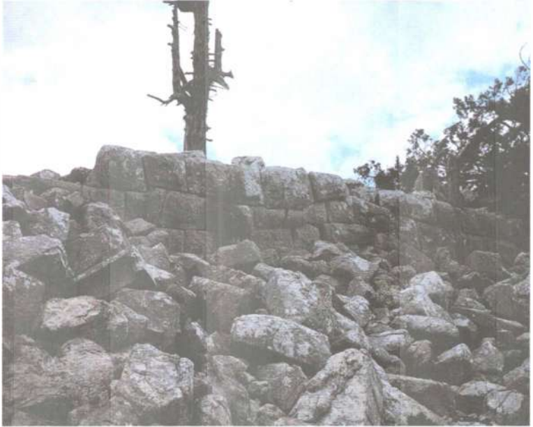
Resim 90. Güney surlarının kalıntılarından bir bölüm.
