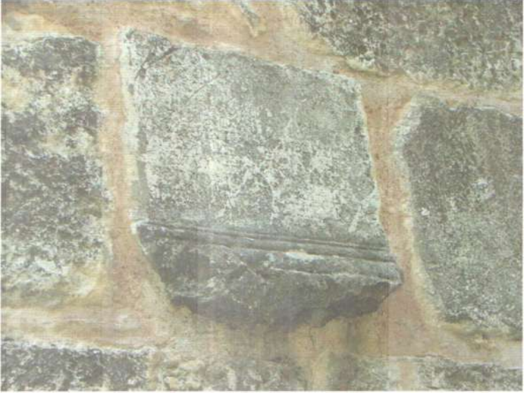
Resim 100. Yapının duvarlarında kullanılmış ilkçağ taşlarından biri: Hellen dilinde bir yazıt.
