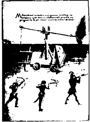
Şekil 17. Tekerlekli mancınık: "Dört teker üzerinde yürütülebilen ahşap gövdeli bu araç, bir kap içinde ateş taşımakta ve mancınık benzeri bu aletle fırlatılan ateş, kale kapılarını, hurçları ve tabyaları ateşe vermektedir" [Mariano di Jacopo Taccola, De rebus militaribus (De machinis) , 1449]. 42
