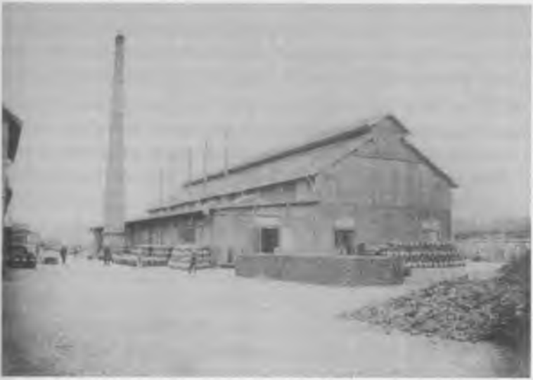
RESİM 57 Bu kimya işletmesi gibi büyük fabrikalar, 1860'larda La Villette gibi banliyö mevkilerinde de ortaya çıkmaya başladı.
