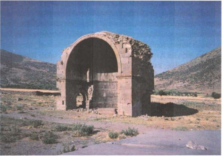
Resim 157. Madenşehir. Halkın Ağzıaçık diye adlandırdığı, 7 No.lu kilise.
