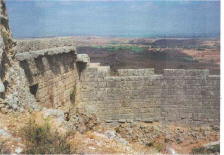
Resim 12. Sillyon. Burç kalıntısı, içten görünüş.
