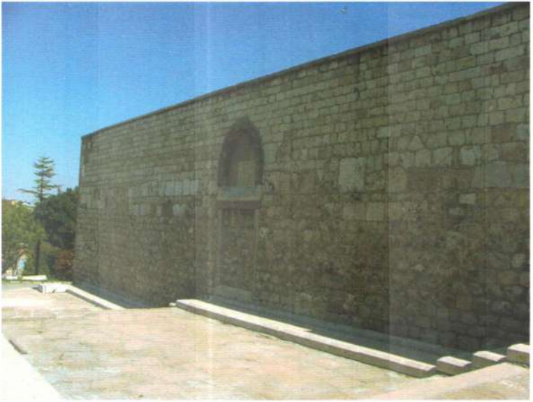
Resim 120. Alaeddin Tepesi'nde Alâeddin Camii yapı kompleksinin yan duvarı ve orada kullanılmış, Roma çağı yapılarından gelme birkaç taş.
