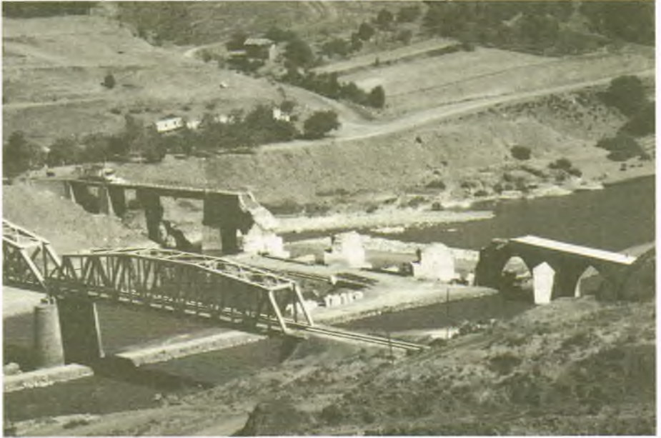
Palu Kalesi'nden eski Palu Köprüsü'nün ve demiryolu köprüsünün görünümü (2009)
