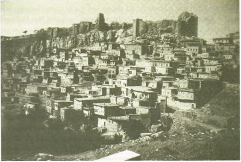
Harpur Ermeni Mahallesi. Merkezde Ermeni Kilisesi görünüyor.
