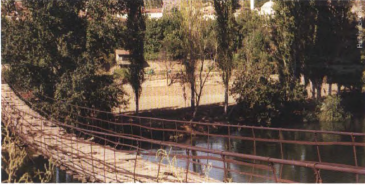
Mihalgazi geçidinde Sanca-Kaya Köprüsü.
