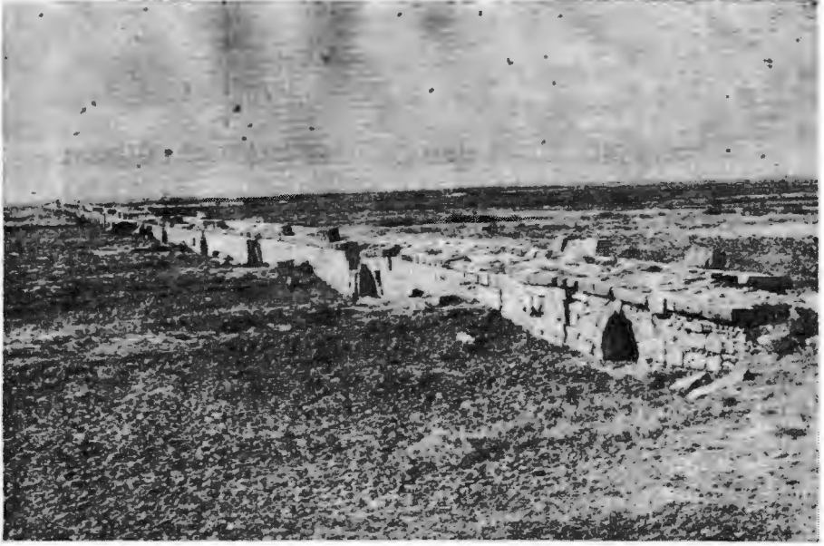
Kırköz Köprüsü (Bolvadin)
