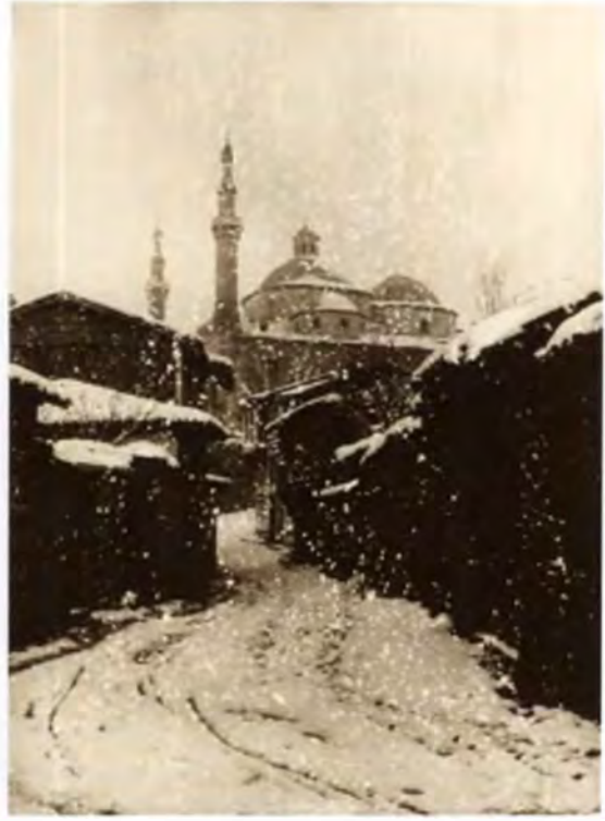
Yeşil Cami Bursa'da karlı bir günde Arif Hikmet Koyunoğlu, 1908
