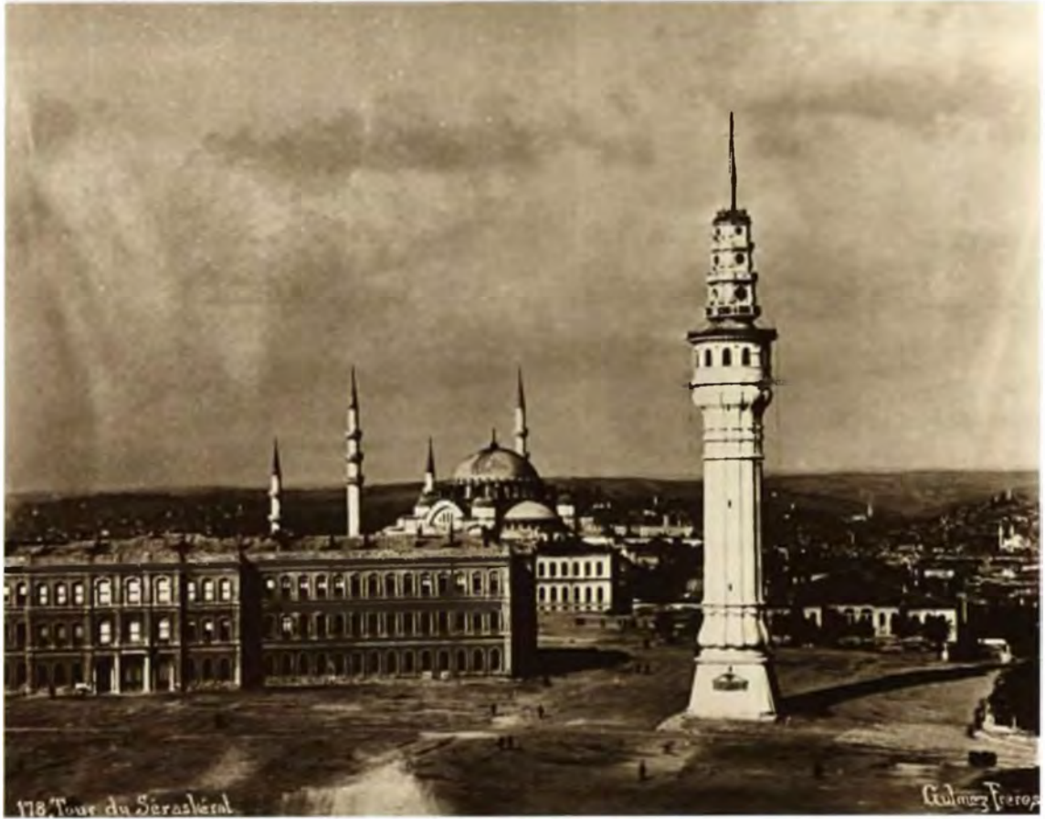
Beyazıt Yangın Kulesi ve Seraskerlik Binası Gülmez Frères, 1880
