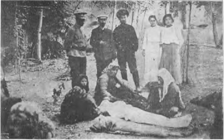
1915 Temmuz ricatında, İğdir (İğdır) parkındaki gıda istasyonu ve salgın hastalık kurbanları
