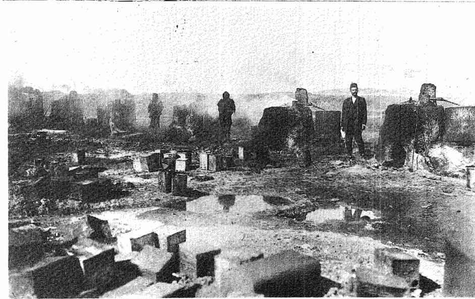
5. Kerkük'e bağlı, Tuzhurmatu kasabası yakınlarında, petrol tasfiyesi için kullanılan ocaklar.
