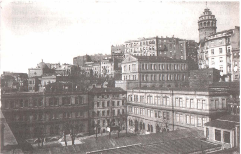
Saint-Benoît Kilisesi, genel görünüm (R. Marmara-Latin Katolik Kiliseler Arşivi).
