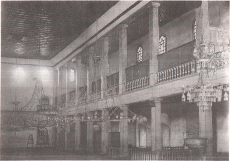
Arap Camii, iç görünüm (R. Marmara-Latin Katolik Kiliseler Arşivi).
