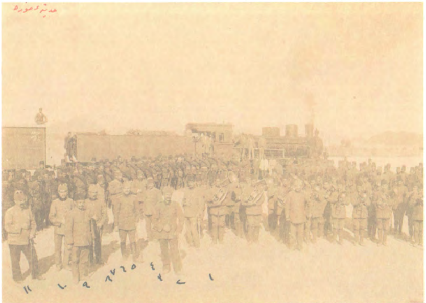
17. Medine istasyonunun açılmasıyla Hicaz demiryolunun önemli bir merhalesinin tamamlanması. İlk trenle Medine'ye birlik takviyesi yapılmıştı.
