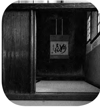
Nijiriguch crawling entrance 60 cm 2 ebatında ay odası kapısı.
