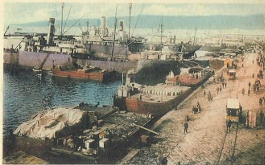
ΣΜΥΡΝΗ. Ἑσωτερικὸν Λιμένος.
