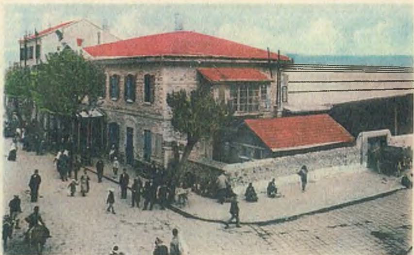
ΣΜΥΡΝΗ. Στδ. Σταθμός Κασαμπά.
