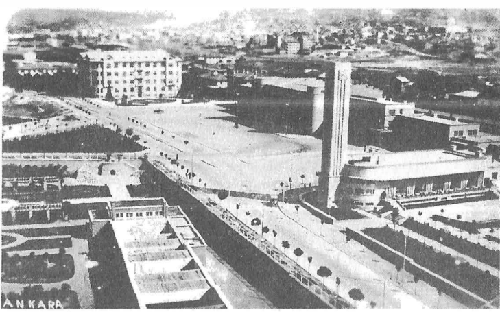
1940'larda Ankara Gar Binası ve Gar Gazinosu, Şekip Akalın, 1935-37.
