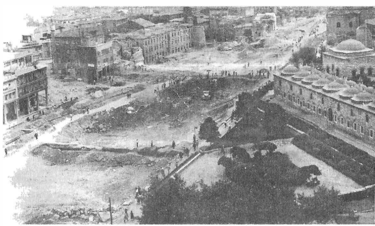
Aksaray ve Beyazıt'ı bağlayan Ordu Caddesi'nin açılma çalışmaları.
