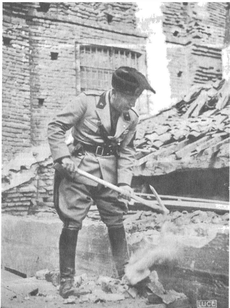
Mussolini, yıkım çalışmalarında ilk kazmayı vururken.
