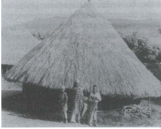
Foto 1: Njago'nun evi: Dallar, yapraklar ve topraktan yapılan bu evde iç duvarlarda sıva malzemesi olarak inek dışkısı kullanılmıştır. Çatının altında, kadınların büyük güçlkle sağladığı yakacak odunlar dikkati çekiyor. Daha fazla eşli, zengin Anugu'nun evi ise tuğla, briket vb. gibi modern malzemeyle yapılmıştır.
