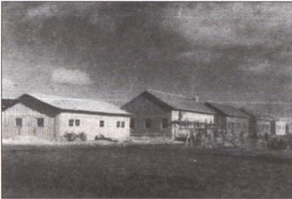
Akpınar Köy Enstitüsü binaları
