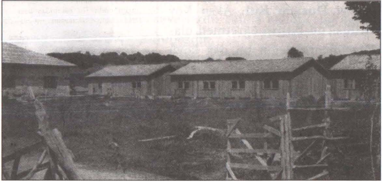
Aksu Köy Enstitüsü binaları
