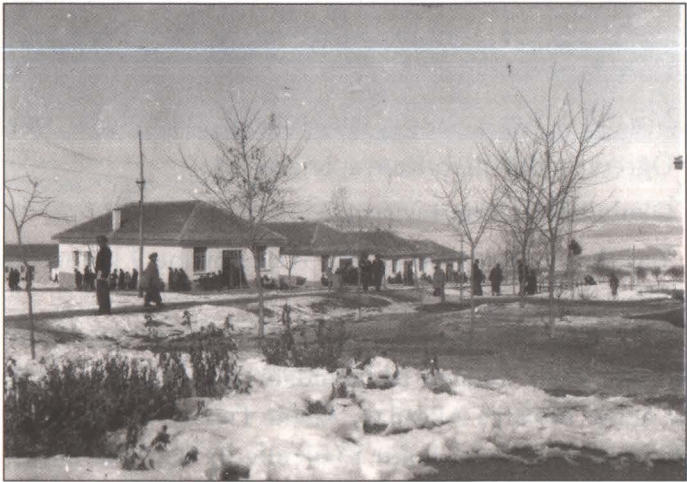
İvriz Köy Enstitüsü yapıları
