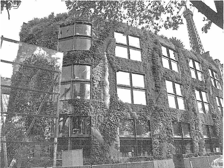
Paris Quai Branly M zesi, dikey baheli cephe.
