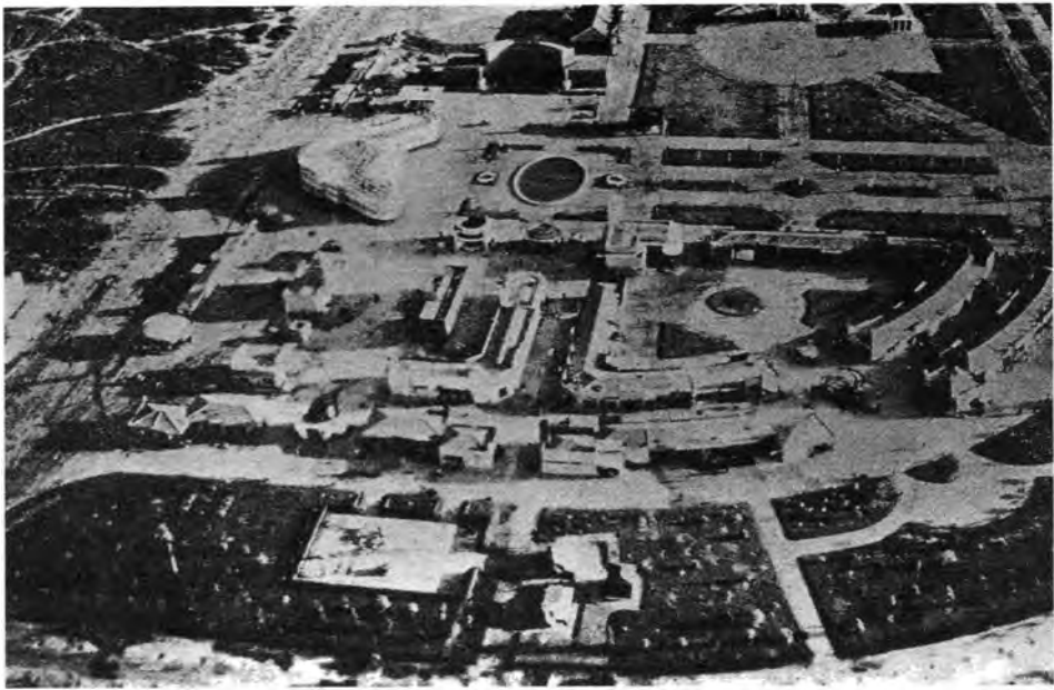
3.20 İzmir Enternasyonal Fuarı'nın üzerine kurulduğu Kültürpark, 1936'da inşaat halinde; fotoğrafta ana girişi (sağda resmin dışında kalıyor) elips şeklindeki havuza bağlayan geniş ana cadde ve fuarın lokanta-gazinosunun V-şeklindeki binası görülüyor. Sergi pavyonları bu caddenin iki yanında kurulur ( Arkitekt 6, no. 10-11, 1936).
