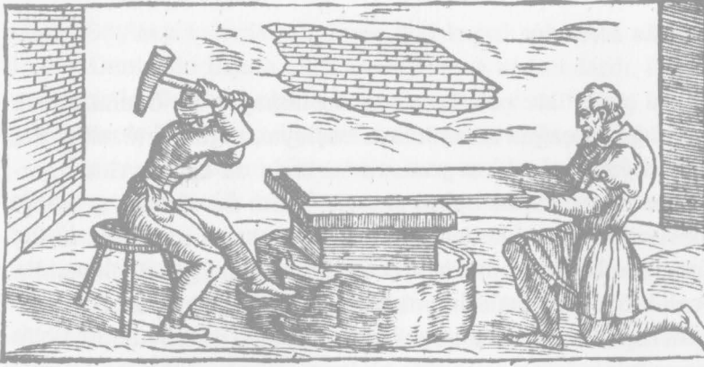
Şekil 42. Pirinç levhaların dövülmesi. Biringuccio'nun De la Pirotechnia 'sından (Venedik, 1540).
