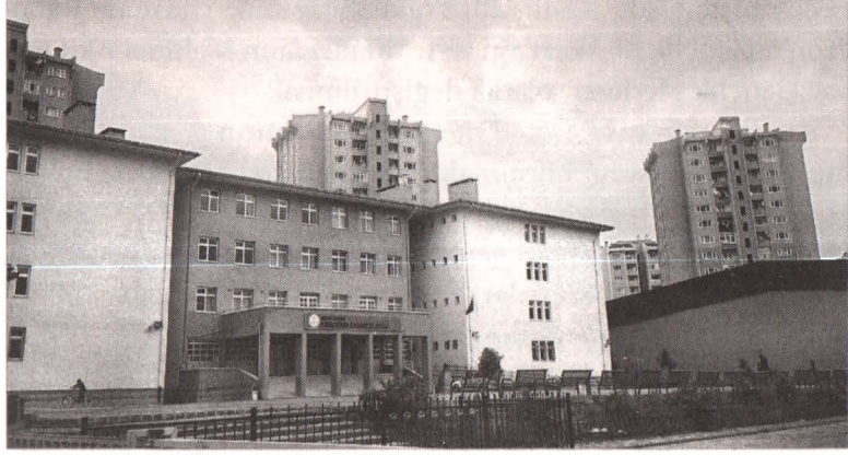
Karacaören İlköğretim Okulu binası.
