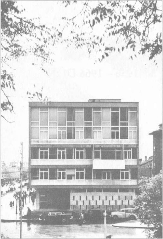
Konya Belediye Sarayı, 1965 (Batı Cephesi güneş kırıcı kafesler belediyece uygulanmadı) Cephe çıplak kaldı.
