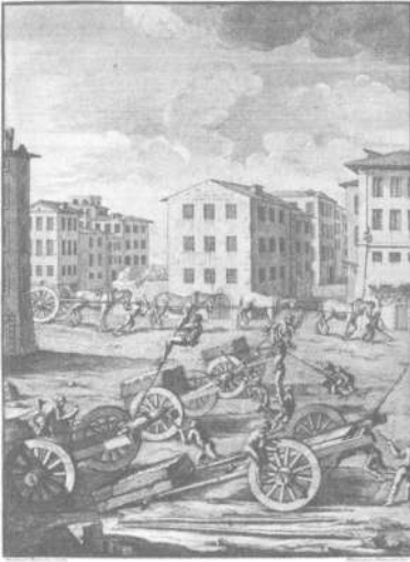
ŞEKİL 99. 18. yüzyılın ilk yarısında Roma'nın inşası için traverten taşlarının taşınması [Niccolò Zabaglia'nın Castelli e Ponti... (Roma, 1743) adlı eserinde, Francesco Rostagni'ye göre Francesco Mazzoni (etk. 1738-1759) tarafından hazırlanan bakır kazıma resim]. 213
