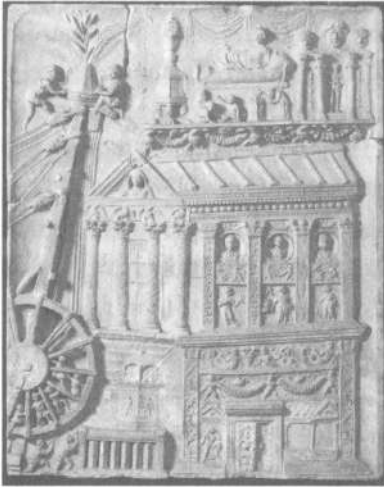
ŞEKİL 25. İmparator Domitianus (yön. 81-96) döneminin bir mezar anıtı üzerinde yer alan mermer kabartmada, Roma’da bir ta-pınak inşaatı sırasında ağır yük kaldırmada kullanılan ayak tepmeli çark ve makara düzeneği ( Museo Lateranense , Roma). 39
