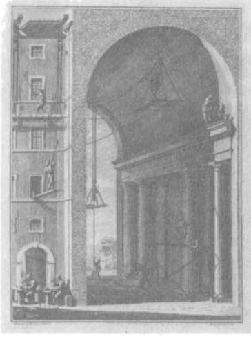
ŞEKİL 101. Roma'da papalık binalarının bakım çalışması: Kurulan iskeleler üzerinde badana ve boya yapan inşaat işçileri (Niccolò Zabaglia'nın Castelli e Ponti... (Roma, 1743) adlı eserinde, Francesco Rostagni'ye göre Giuseppe Vasi (1710-1782) tarafından hazırlanan bakır kazıma resim). 213
