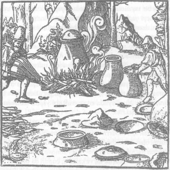
ŞEKİL 106. Bitümlü kayalarından bitümün eritilerek çıkarılması. 230
