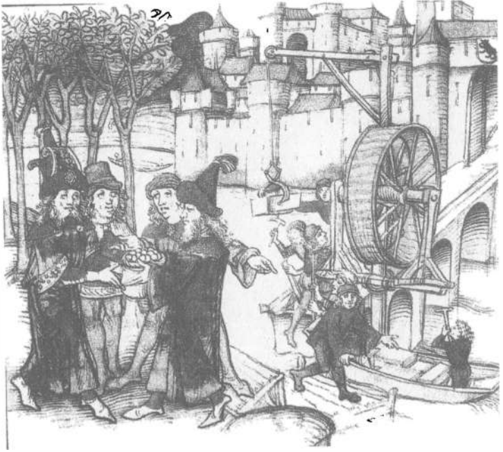
ŞEKİL 111. Ortaçağ Avrupa'sında su kanalı yoluyla getirilen taşların, özel olarak kurulan köprü ve vinç yardımıyla teknedan boşaltılması. 192
