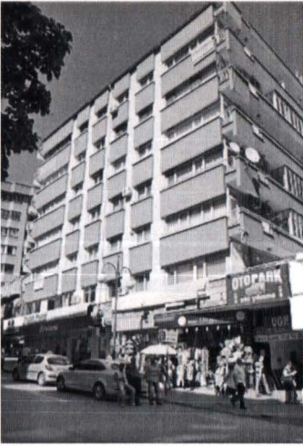
Resim 9. Talip ve Başkent Apartmanı'nın cepheleri ve cephelerde yer alan güneş kırıcılar.
