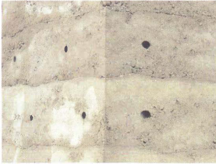
RESİM 57, 58 Bruder Klaus Şapeli'nin üretim süreci. Üstte şapelin iç mekân kalıbını oluşturduktan sonra yakılan ahşap çatki. Altta dış yüzeye sıvanan betonun üretim etapları ve içeriden gömülerek yıldız efekti verecek lupların montajı için bırakılan boşluklar.
