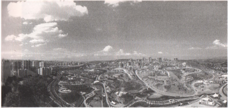
2.10 Kuzey Ankara proje sahası: (soldan sağa) hak sahipleri yerleşkesinin çokkatlı blokları (inşaat halindeki külliye uzaktan görünmektedir), yeri değiştirilmiş havalimanı yolu, rekreasyon alanı, inşaat halindeki lüks konutlar. Fotoğraf: Bülent Batuman.
