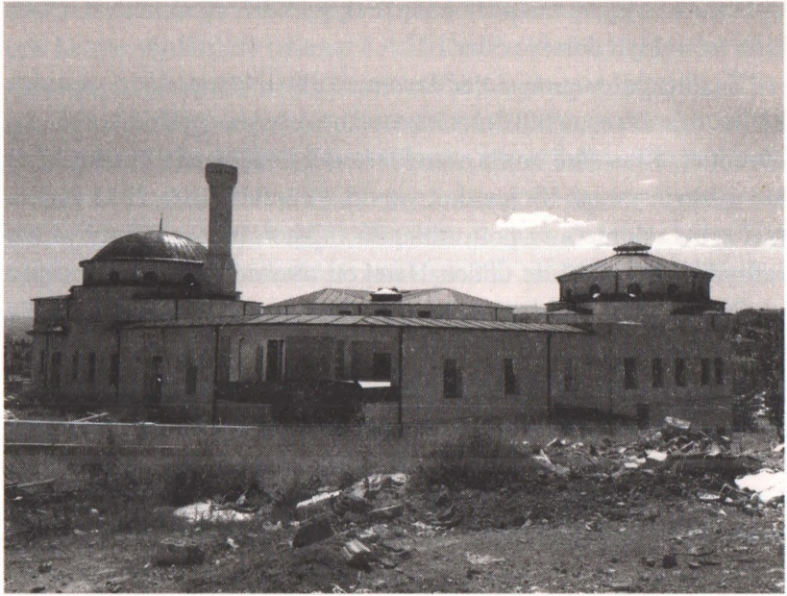
1.16 Cami-Cemevi kompleksi, Ağustos 2016: Aşevinin çatısı cami ve cemevininkinden ayrıdır; camiye doğrudan, cemevine ise avludan geçilerek girilir. İnşaat durduktan sonra minarenin üst kısmı yıkılmıştır. Fotoğraf: Bülent Batuman.
