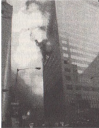
d. DTM 7 binasının güneybatı tarafından çekilmiş olan, yangının ve yapısal hasarın gerçek boyutunu ortaya koyan görüntüsü. FOTOĞRAF FEMA'NIN İZNİYLE KULLANILMIŞTIR: http://www.fema.gov/pdf/library/fema403_ch5.pdf .
