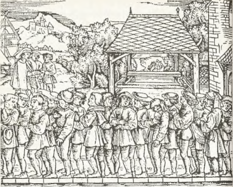
ŞEKİL 47. Jakob Köbel'e (1460-1533) göre "ortalama ayak" uzunluğunun belirlenmesi yoluyla "bir ölçüm çubuğunun üretilmesi" işlemi (1584): Olasılıkla kilisedeki törenden çıkan on altı adam, sol ayaklarını uç uca yerleştirmekte; toplam uzunluk, on altıya bölünerek bir "ayak" uzunluğu saptanmaktadır (J. Köbel, Geometrey. Von künstlichem Feldmessen und absehen , Frankfurt a. M., 1608). 60
