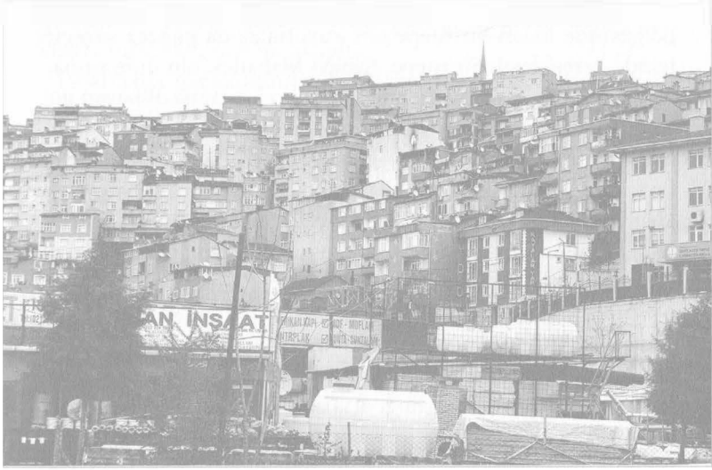
Sanayi Mahallesi'nde, dip dibe geçmiş apartmanlar.
