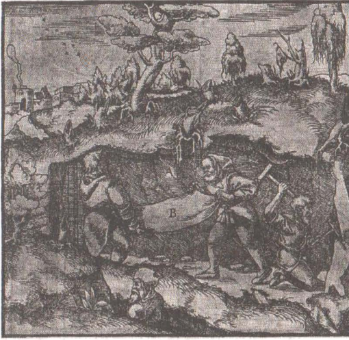
Şekil 32. Sağdaki işçi, madenci çekici ve keski ile duvarı kazmaya çalışırken, soldaki iki madenci, bir bezi sallayıp yelpazeleyerek maden galerisini havalandırmaktadır (G. Agricola, De re metallica , 1556). 16, 39
