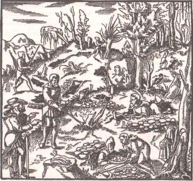
Şekil 24. Maden aramada çatal çubuk kullanımı ve sondaj çalışmaları (G. Agricola, Bergwerksbuch, Basel, 1557). 37
