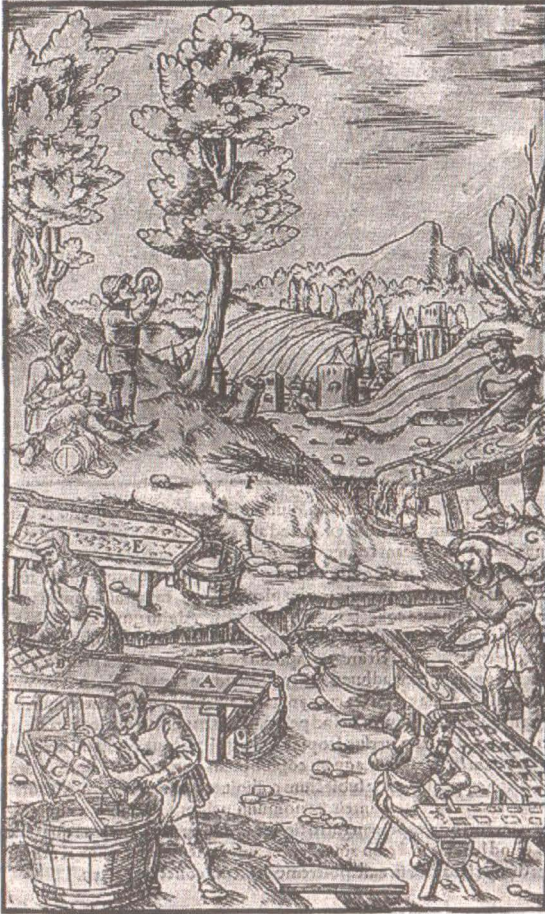
Şekil 34. Thüringen'de çeşitli modeldeki tezgâhlar üzerinde altın yıkama işlemi (G. Agricola, De re metallica, 1556). 59
