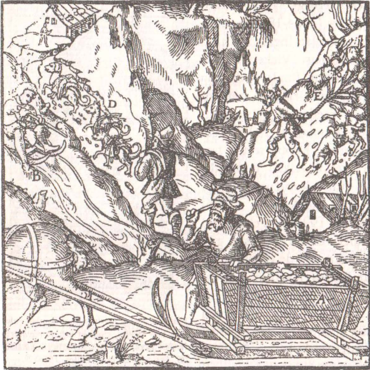
Şekil 27. Maden ocagında çeşitli hayvanlar aracılığıyla taşımacılık: A- Sandıklı kızak; B- Çuval taşıyan kızak; D- Sırtlarına seker şeklinde torbacıklar bağlanmış köpekler; E- İplerle birbirine bağlanmış domuz derisinden torbacıklar (G. Agricola, De re metallica, 1556). 34
