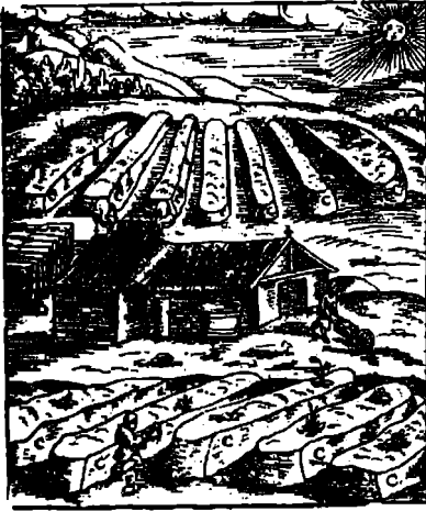
Şekil 43. Ercker'e göre, olgunlaştırma yatakları ve buharlaştırma evi ile birlikte güherçile işletmesi: A- Güherçile toprağın güherçilenin yıkanarak toplandığı yer, B- Güherçile çözeltisinin buharlaştırıldığı yer, C- Güherçilenin "olgunlaştırıldığı" yer (L. Ercker, Beschreibung... , Frankfurt / M., 1598).
