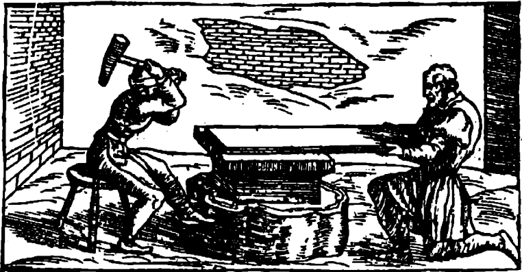
Şekil 40. Biringuccio'nun De la pirotechnia 'sından pirinç levhaların dövülmesi (Venedik, 1540). 66
