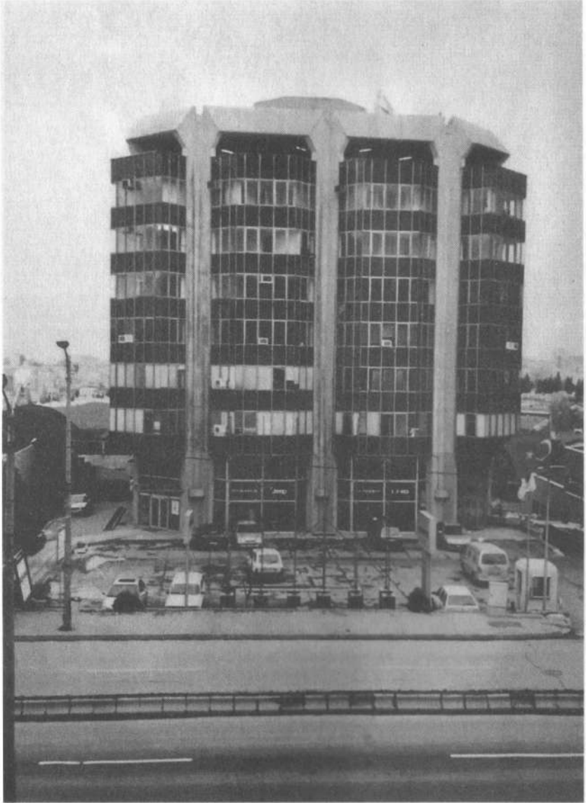
Mimar Abdurrahman Hancı tarafından yapılan Tatko Binası, Mecidiyeköy. Daha sonra bu bina yıkılarak yerine bugünkü kuleler yapıldı.
