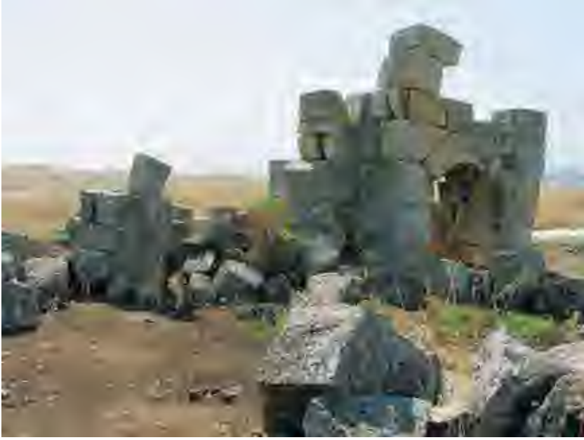
Res. 67c Batı Hamamı, caldarium bölümü.
