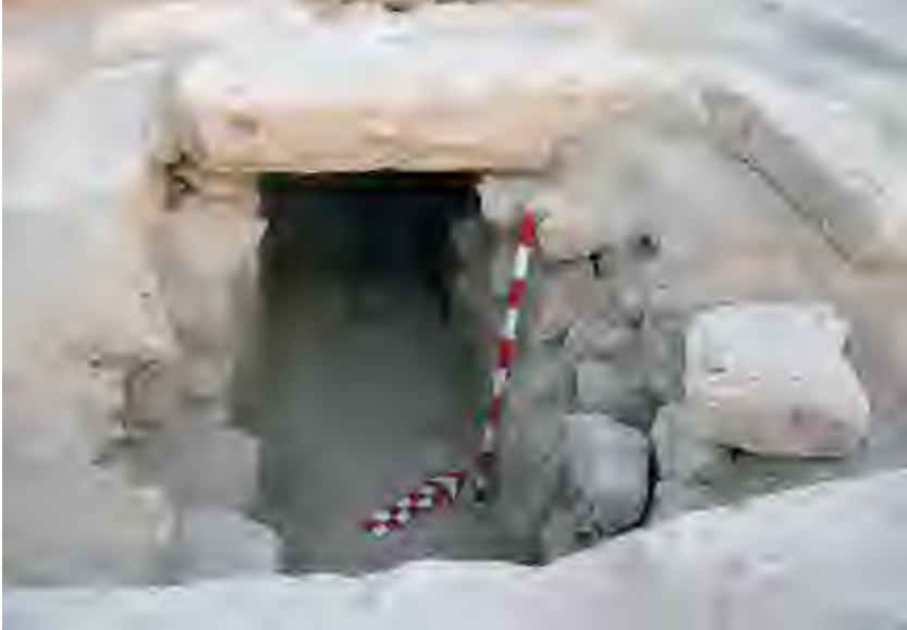
Res. 47k Suriye Caddesi ortasında yer alan ana kanalizasyon sistemi ve iki yandan bağlanan atık su boruları.
