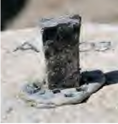
Res. 55g A Nymphaeumu'na ait Korinth başlığındaki kenet detayı.
