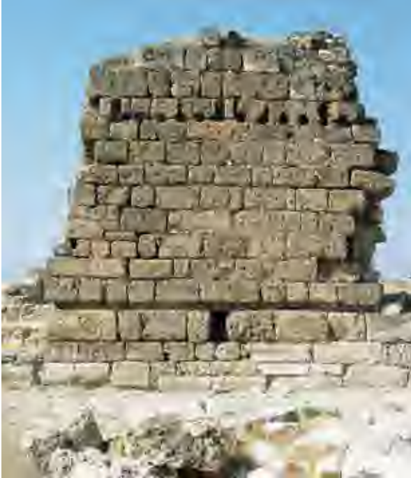
Res. 60b Merkezi Hamam'ın kuzey duvarından sıralı hatıl yuvaları.
