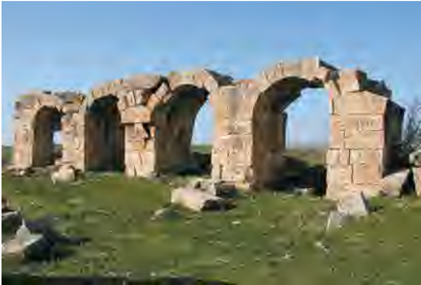
Res. 66d Güney Hamam-Gymnasium kompleksi apodyterium bölümünün kemerli kuzey duvarları.
