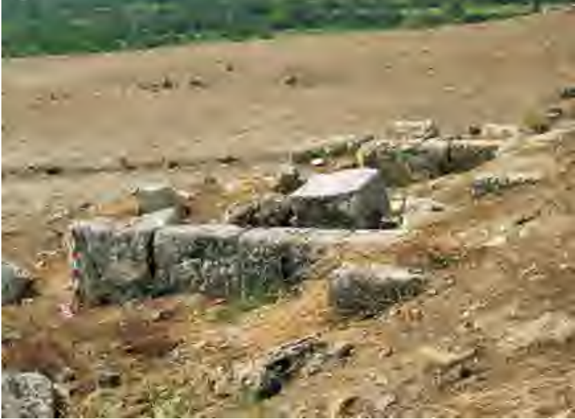
Res. 46d Erken Bizans Dönemi surlarından güneydoğu kulesi.
