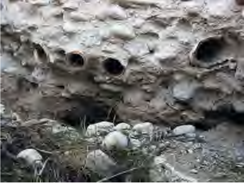
Res. 31b II. Su Dağıtım Terminali'nden pişmiş toprak borular.
