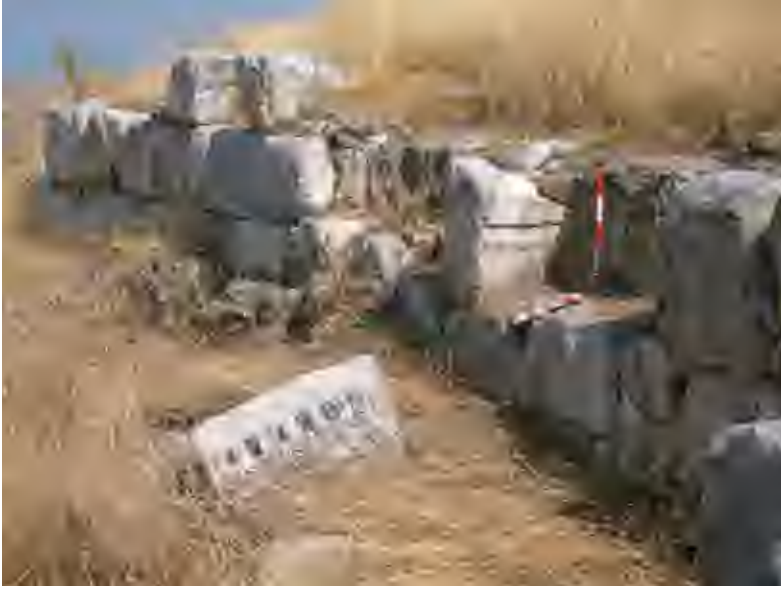
Res. 96a Kuzeybatı Bazilikası'nın batısındaki devsirme örgü duvar.
