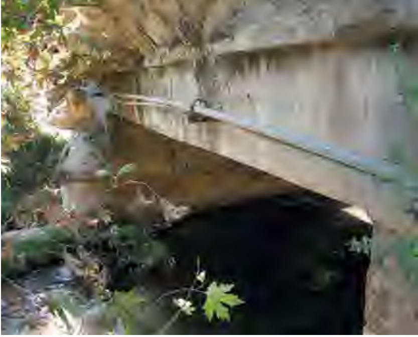
Res. 37b Akhan Kervansarayı yanındaki Karakurt Çayı üzerinde yer alan köprü.
