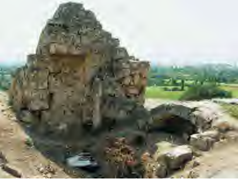
Res. 30c I. Su Dağıtım Terminali yanındaki çeşme yapısı ve tonozlu geçiş.
