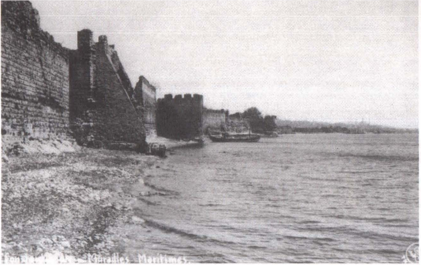
Sahil yolu yapılmadan önce Marmara deniz surlarının görünümü.
