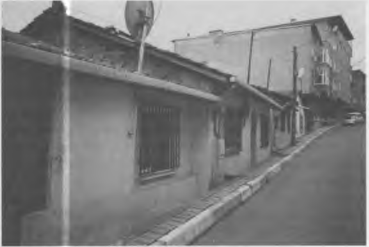
Resim 5.4 1 Mayıs Mahallesi'nde günümüze ulaşabilmiş birkaç gecekondu.
