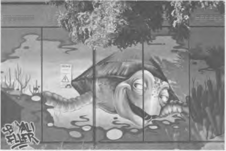
Resim 8.10 Güngören’de elektrik trafosu üzerine uygulama, sanatçı: Boyalı Eller Crew, 2012.
