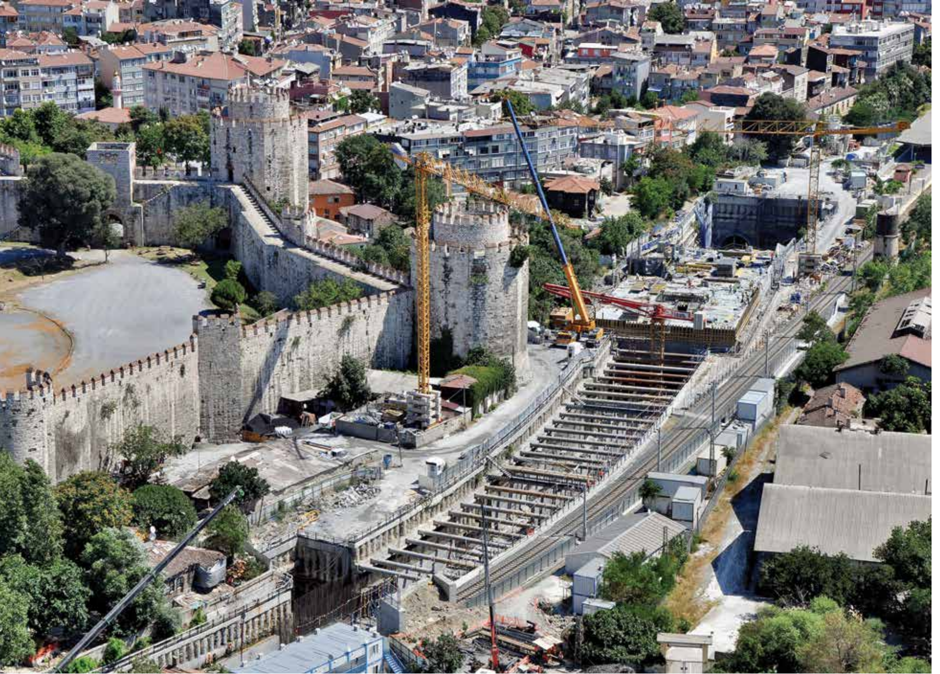
YENİKAPI İSTASYONUNDA, ŞEHİR YAŞAMI VE TARİHİ DOKU İLE İÇ İÇE YÜRÜTÜLEN ÇALIŞMA, ANCAK MARMARAY GİBİ DÜNYA ÇAPINDA BİR PROJENİN BAŞARABİLECEĞİ BİR İŞTİ.
