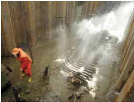
YK 2 ÇEKİRİŞİNİN KAZISI SIRASINDA KULLANILAN ÜSTTEN SULAMA SİSTEMİ, 2006 YAZI.
