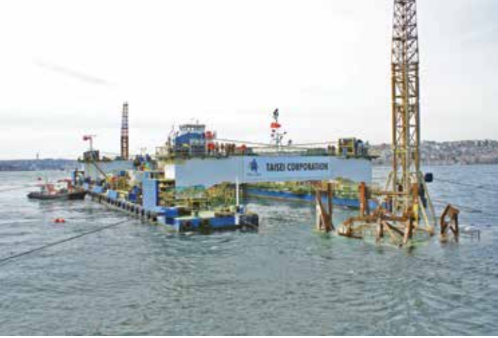
İMAL EDİLEN TÜP TÜNEL ELEMENLARI DENİZ TABANINA KAZILAN HENDEKLERE TEK TEK İNDİRİLİYOR.
