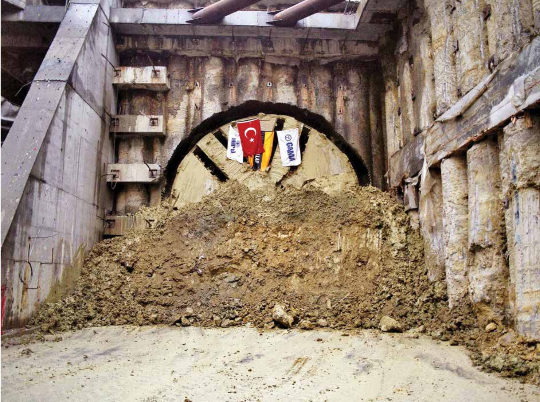
YENİKAPI İSTASYONUNDA DELME İŞİNİN TAMAMLANDIĞI AN (ARALIK 2011).
