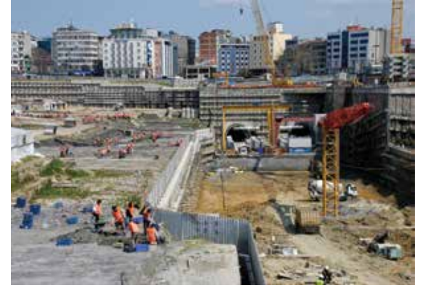
RESİM 1: MARMARAY-METRO KAZI ALANINDAN GENEL GÖRÜNÜM (FOTOĞRAF: B. KÖŞKER).
