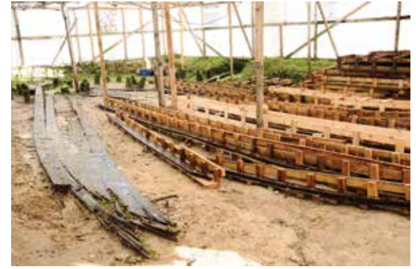
RESİM 17: KAPLAMALARIN YERİNDEN KALDIRILMASI ÇALIŞMALARI.
