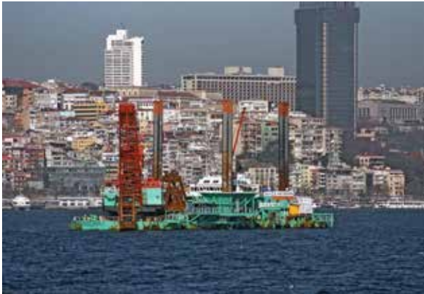
TÜNEL ELEMANLARI, ÖZEL DONANIMLI DENİZ EKİPMANLARIYLA DENİZ TABANINDAKİ HENDEK İÇİNE YERLEŞTİRİLİR.
