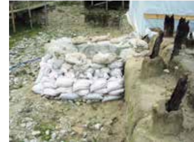
RESİM 7: BATIKTA BİRİKEN SUYUN DIŞARI ATILMASI İÇİN YAPILAN ATIK SU HAVUZU.
