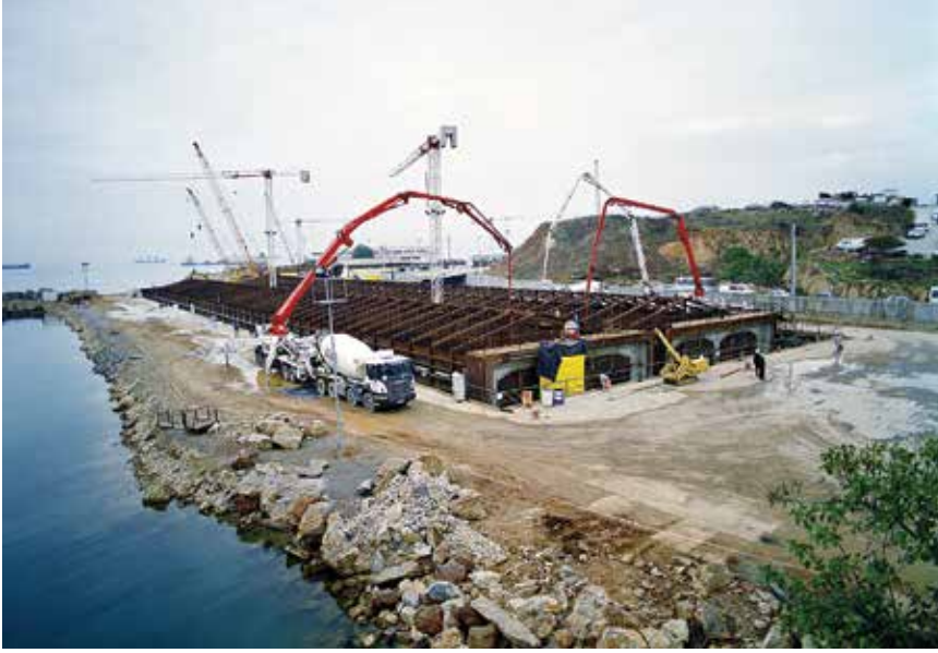
BATIRMA TÜP TÜNEL, 11 ADET ELEMANDAN OLUŞUYOR. 100-135 METRE UZUNLUĞUNDAKİ TÜPLERİN İMALATI TUZLA TERSANELERİNDEKİ KURU HAVUZLARDA YAPILDI. RÖMÖRKÖRLERLE ÖNCE BÜYÜK KADA AÇIKLARINA ÇEKİLEREK TEST EDİLDİ, ARDINDAN PROJEDEKİ YERİNE TAŞINDI.
