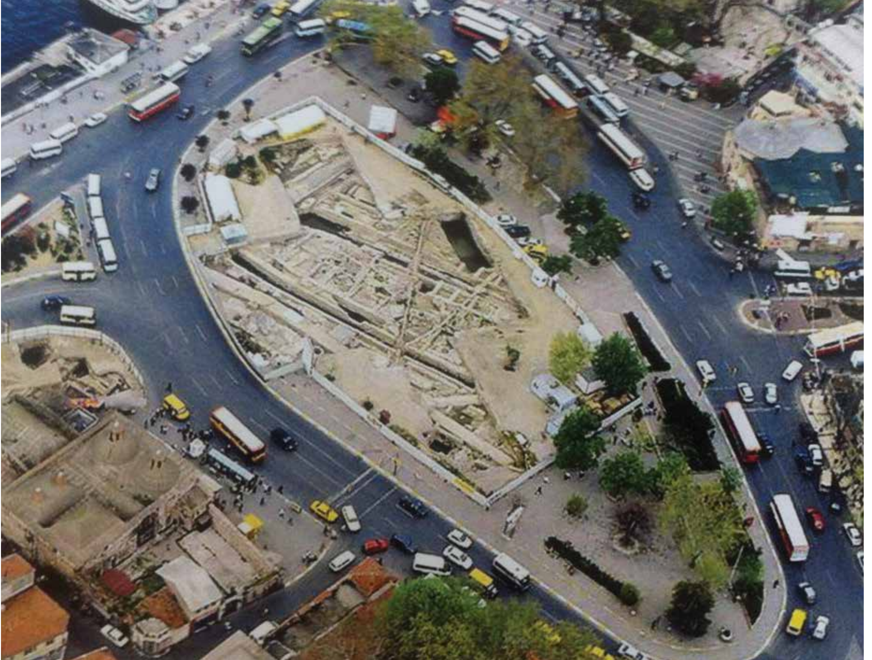
MARMARAY ÜSKÜDAR MEYDANI KAZI ÇALIŞMALARI HAVA FOTOĞRAFI.
