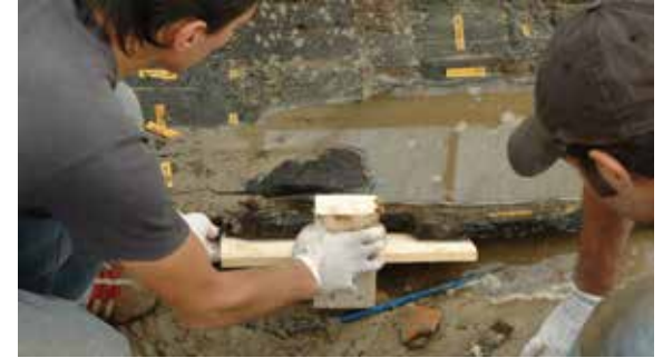
RESİM 18: KAPLAMALARIN ALTINA “L” PROFİLLİ TAŞIYICILARIN YERLEŞTİRİLMESİ.
