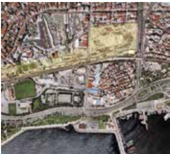
RESİM 2: MARMARAY YENİKAPI-METRO KAZI ALANININ GENEL GÖRÜNTÜSÜ.
