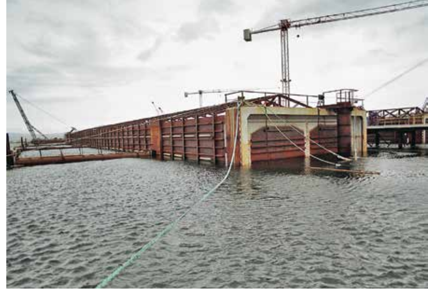
BATIRMA TÜP TÜNEL, 11 ADET ELEMANDAN OLUŞUYOR. 100-135 METRE UZUNLUĞUNDAKİ TÜPLERİN İMALATI TUZLA TERSANELERİNDEKİ KURU HAVUZLARDA YAPILDI. RÖMÖRKÖRLERLE ÖNCE BÜYÜK KADA AÇIKLARINA ÇEKİLEREK TEST EDİLDİ, ARDINDAN PROJEDEKİ YERİNE TAŞINDI.
