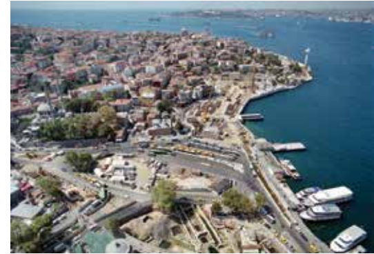
RESİM 25: MARMARAY, ÜSKÜDAR İSTASYONU KAZI ALANLARI GENEL GÖRÜNÜMÜ.
