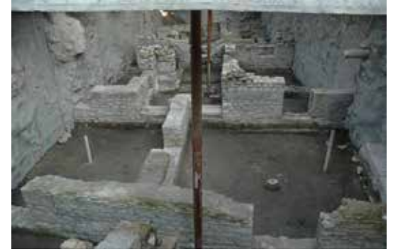
RESİM 20: MARMARAY, SİRKECİ İSTASYONU, KUZEY GİRİŞ KAZI ALANI .
