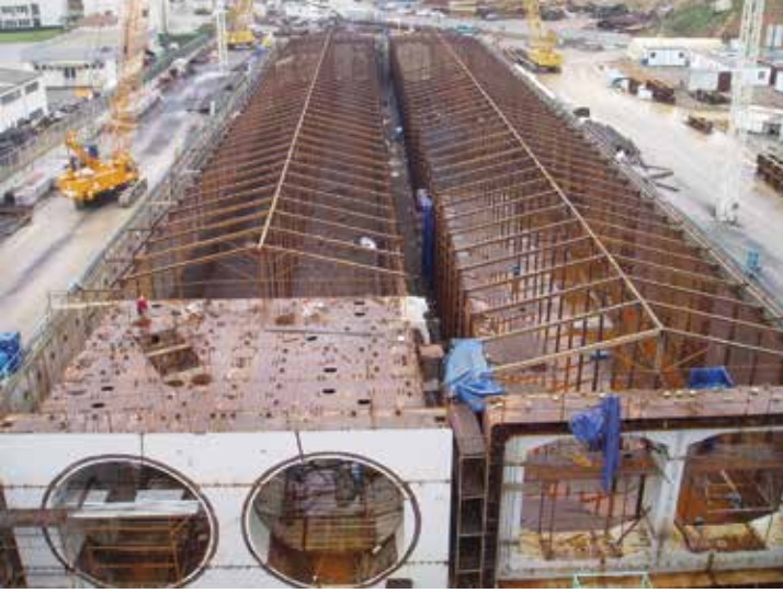
TUZLA'DA KURU HAVUZDA TÜP TÜNEL ELEMENLARININ İMALATI.
