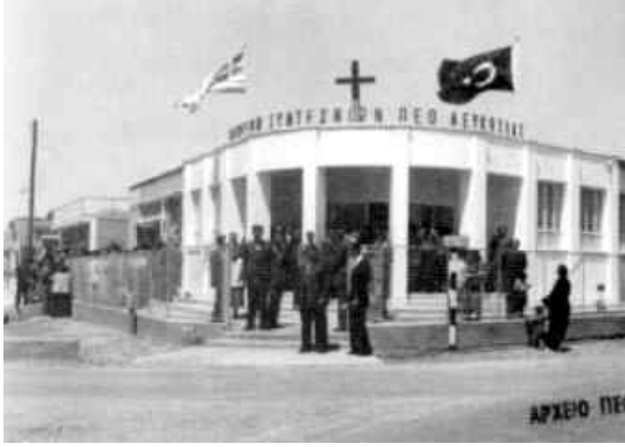
1952-1974 yılları arasında PEO kliniği olarak işlev gören bina. Bu binanın yapımında Kıbrıslı Rum ve Kıbrıslı Türk emekçiler gönüllü olarak çalıştılar.
