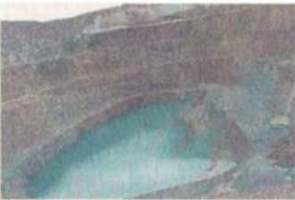
Altın madeninde civa içeren atıksu barajı
