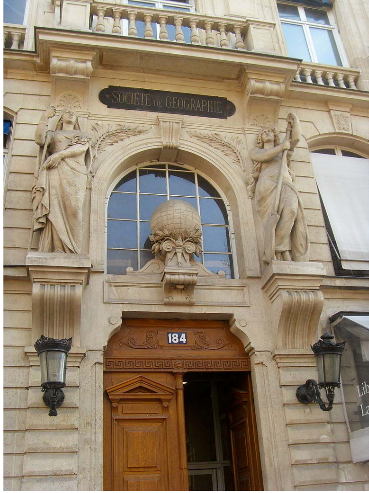
Resim 107: Soci  t   de G  ographie'nin Paris'teki merkez binası
