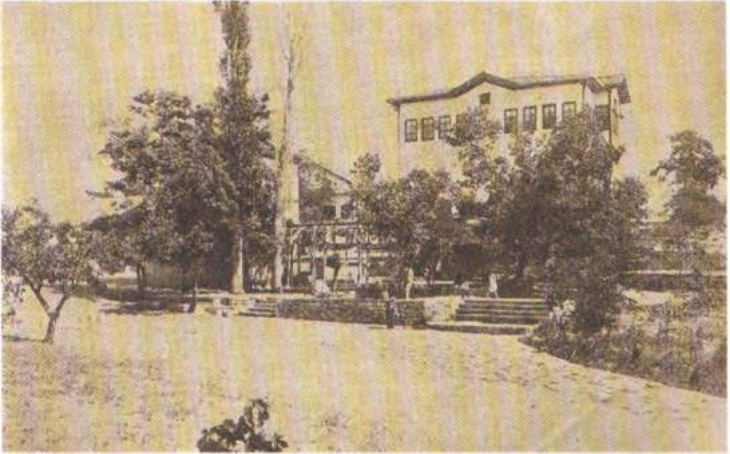
“Hemayei Etfalin Anakucağı binası”
