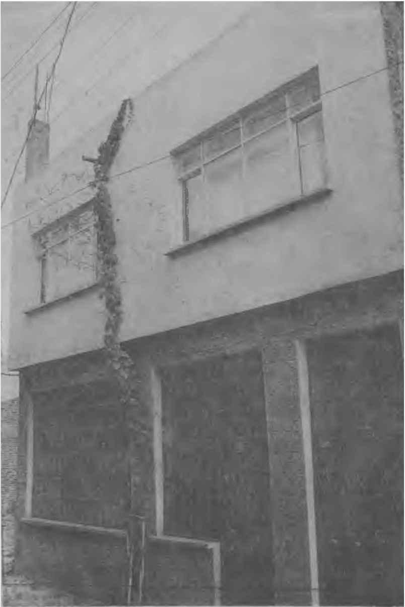
Bursa küçük dokuma sanayiinde işyeri, konut birlikteliğine bir örnek: alt katı dokuma işyeri, üst katı ise konut olan bir bina. (Bu bölümdeki tüm fotoğraflar Güliz Dokumcu tarafından çekilmiştir. Kendisine teşekkür borçluyum. A.A.)
