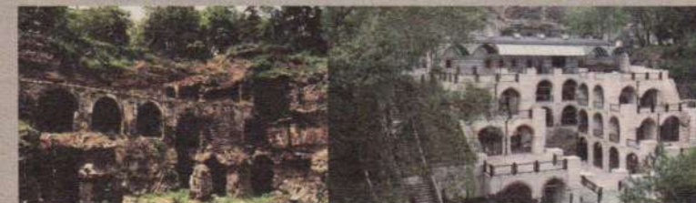
15. yy'dan kalma Bursa Balıkbey Han restore edilerek kafeye dönüştürüldü.
