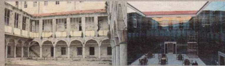
Atik Valide Külliyesi'nin şifahanesi de restorasyonla tanınmaz hale geldi. Şifahanenin iç bahçesine bakan revakların önü tamamen camla kaplandı ve iç bahçeye otomatik kapılar yapılarak kafeteryaya çevrildi.
