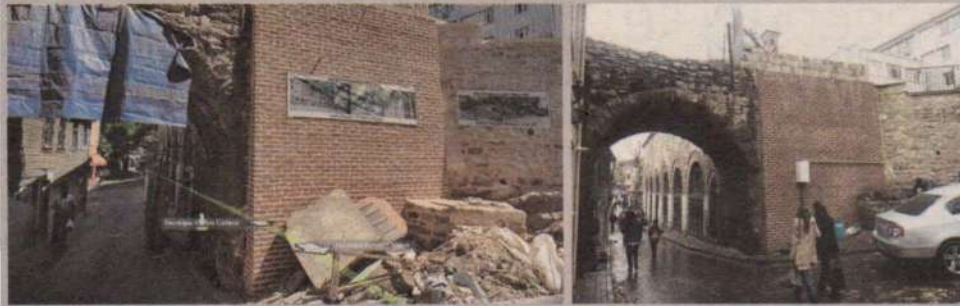
İstanbul'da 1600 yıllık Bozdoğan Su Kemerı'ne doğalgaz borusu döşendi.
