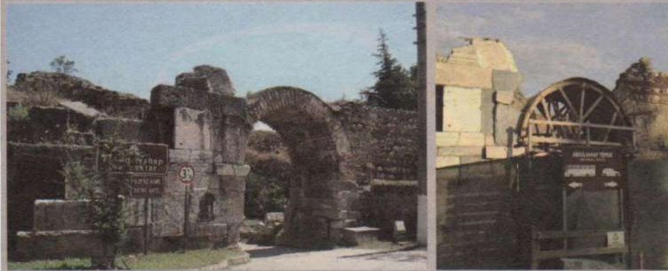
Izmir Lefke Kapı'da devam eden restorasyon kapsamında, tarihi kapının üst kısmındaki kemer, tehlike arz ettiği gerekçesiyle yıkıldı.
