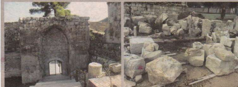
Antalya Korkuteli'nde Selçuklu dönemi stilinde yapılan yaklaşık 800 yıllık Alaaddin Cami restorasyonu sırasında Divriği Ulu Cami Darüşşifası'na benzer taş kapı yıkıldı.
