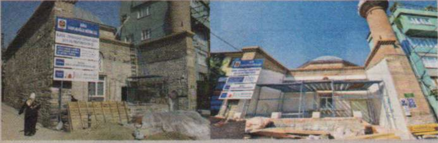
Bursa'da 14. yüzyılda inşa edilen Yerkapi Camii'nin tarihi duvarları restorasyon adı altında çimentolu sıvayla kaplandı.
