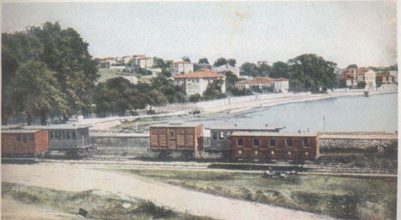
1910'larda Haydarpaşa'dan Kadıköy'ün görünüşü.
